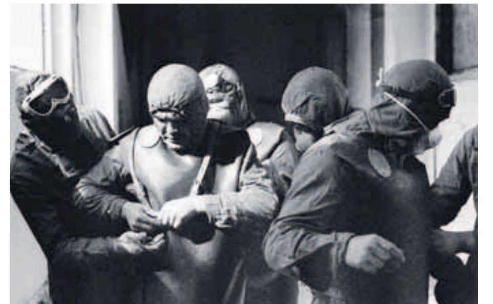
Aufräumarbeiter bereiten sich auf ihren Einsatz auf dem Dach des Kraftwerks vor.
