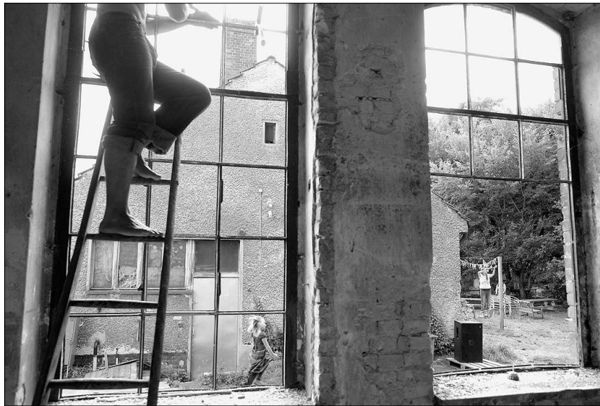
Rund 30 Wohnungen verschiedener Größe sollen in dem alten Rittergut entstehen, dazu Handwerk und andere Betriebe. FOTOS: SANTIAGO ENGELHARDT
