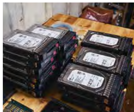
NACHSCHUB: Neue Festplatten für den Einbau in die Serverschränke.
